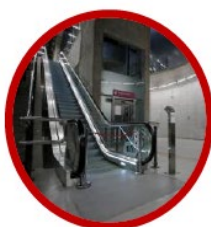
Escaleras Mecánicas y Ascensores en todas las Estaciones
