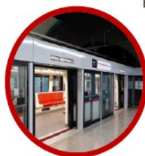
Puertas de Andén
