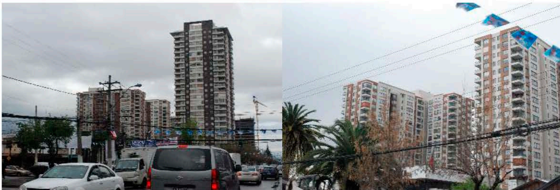
Figura 3.5: Edificios residenciales. Fuente: Elaboración propia
